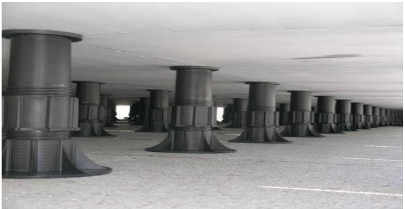
Hochfeste Kunststoff-Stützen als höhenverstellbare Unterkonstruktion
